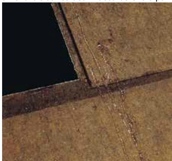
Fig. 2 La languette verticale du panneau Celit 4D évacue l'eau au-dessus de la languette horizontale, ce qui permet à l'eau arrivant en bas du joint de s'écouler vers le panneau du dessous.
