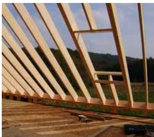
Fig. 18 Utilisation d'un gabarit pour la réalisation du chevêtre
