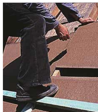
Fig. 8 Placement des panneaux
